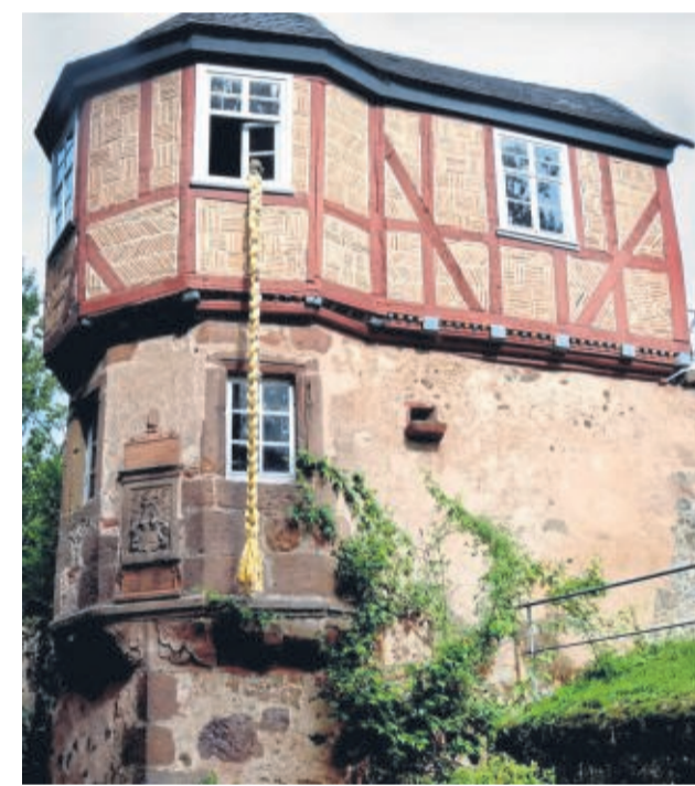
Langer Zopf aus dem Fenster: Der Rapunzelturm als Teil des Amónauer Schlosses ist denkmalgerecht saniert worden.
